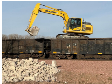
Posizionamento di rip rap in SD
